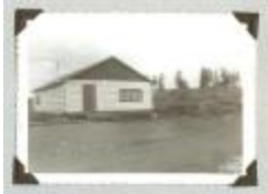
Bâtiments en 1962 (45p-c000006-Batiments en 1962)
