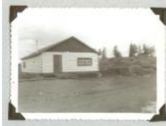
Bâtiments en 1962 (45p-c000006-Batiments en 1962)
