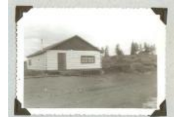
Bâtiments en 1962 (45p-c000006-Batiments en 1962)
