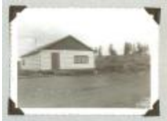
Bâtiments en 1962 (45p-c000006-Batiments en 1962)
