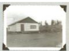
Bâtiments en 1962 (45p-c000006-Batiments en 1962)
