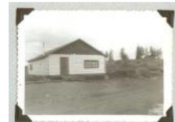
Bâtiments en 1962 (45p-c000006-Batiments en 1962)
